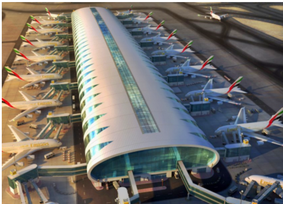
Terminal Concourse A para A380
